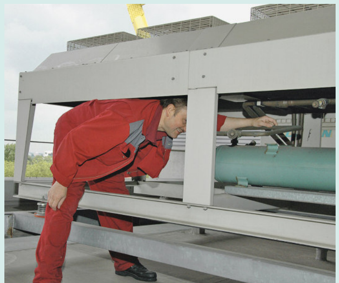
Bei der Wartung der Filterregister der Klimaanlage kommen ebenfalls die Vogt-Mitarbeiter zum Einsatz.
