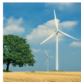
Technische Wartung von Windkraftanlagen
