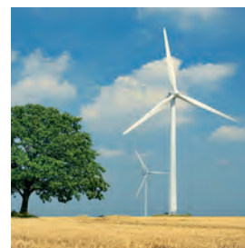
Technische Wartung von Windkraftanlagen
